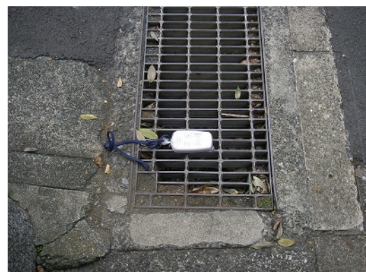
F 団地入口グレーチング上(下流側).j... 2012/10/28
