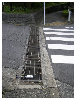
E 団地入口グレーチング上(下流側).j... 2012/10/28
