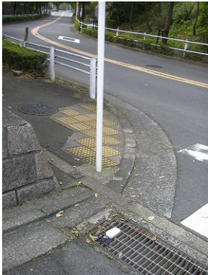
A 団地入口グレーチング上(上流側).j... 2012/10/28
