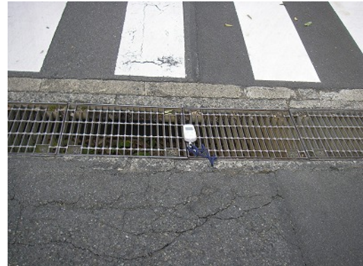
C 団地入口グレーチング上(中央部... 2012/10/28
