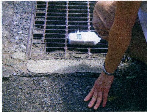
11 スポットの測定 測定点J (0.128... 2012/07/15
