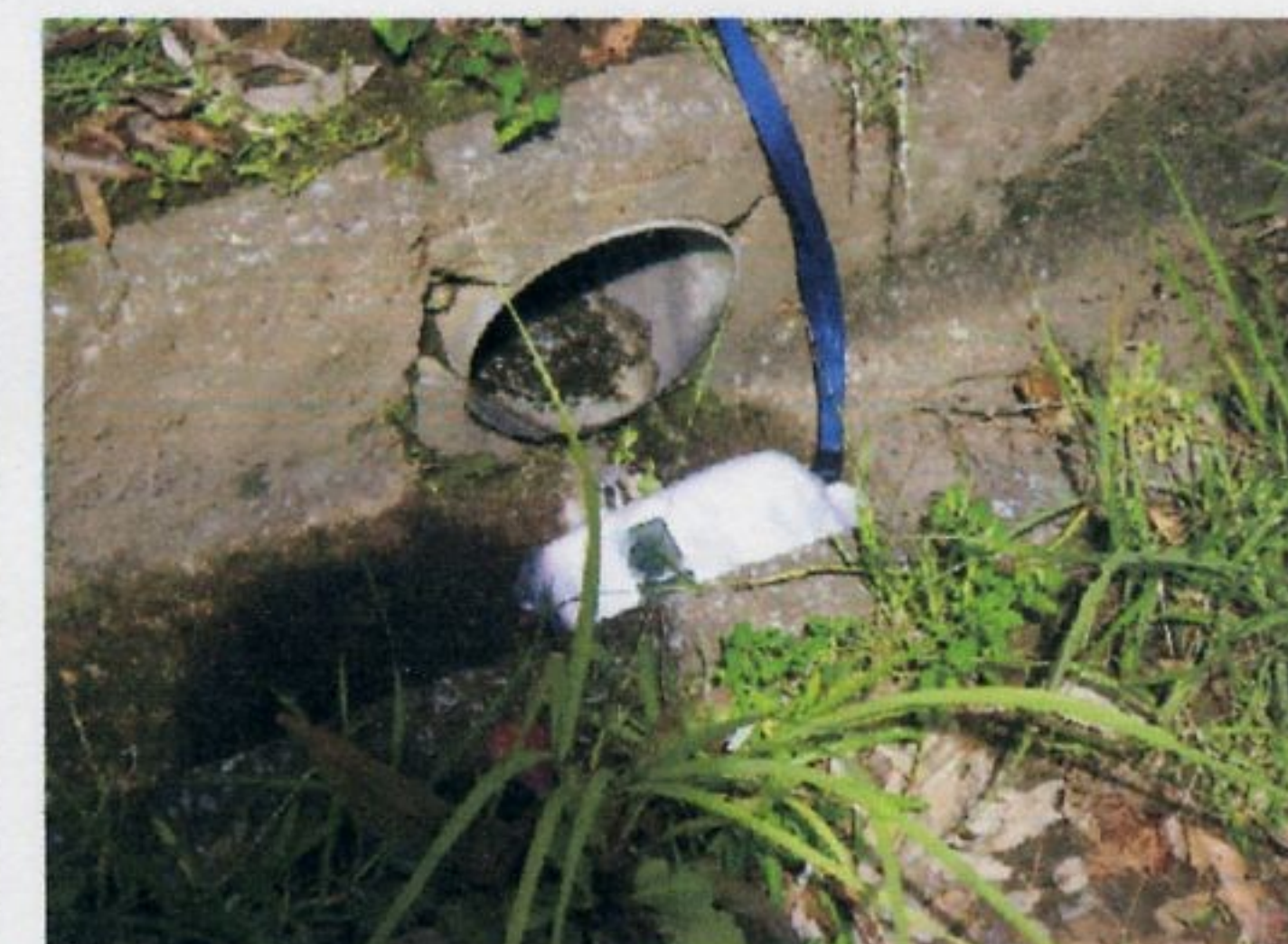
09 スポットの測定 測定点H (0.277... 2012/07/15
